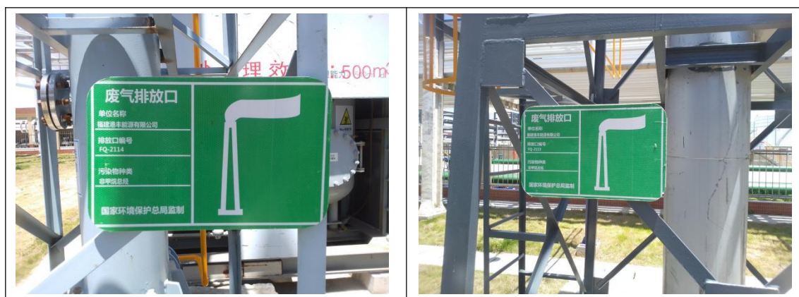
图 4.2-9 排放口标识牌
